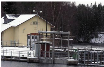
Hammar, Suède • Installateur: Olab AB.
