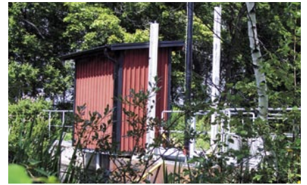
Local typique pour centrale hydraulique à eau.
