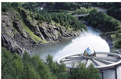
Naussac, France • Installateur: Fluid Hydr'Eau.
