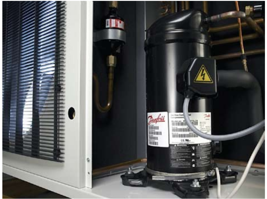
Спіральний компресор у компресорно-конденсаторному агрегаті «Оптыма PLUS™»
