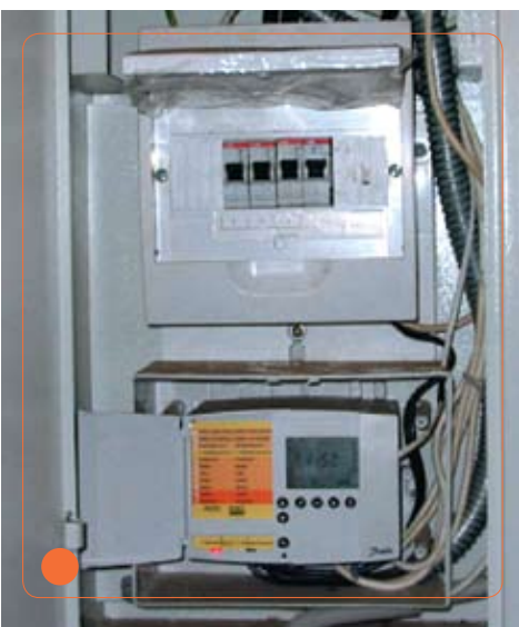
Рис. 5. Шкаф с контроллером ECL Comfort
