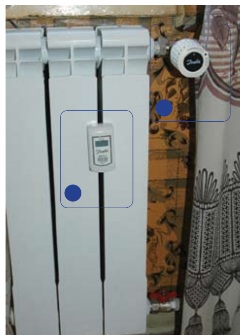
Рис. 1. Радиатор «Сантехпром БМ» с терморегулятором и счетчиком-распределителем
