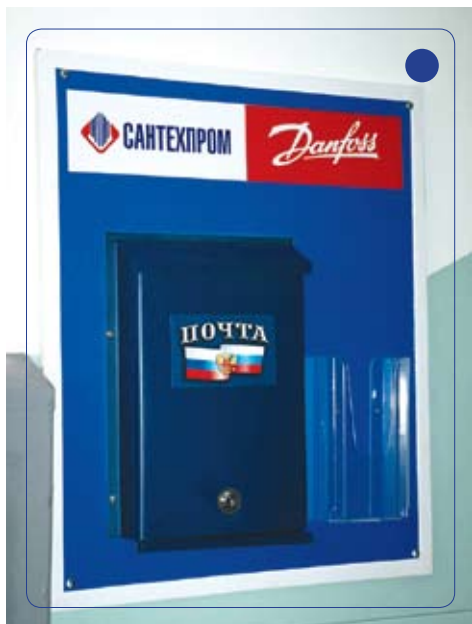
Рис. 2. Почтовый ящик для снятия показаний с радиаторных распределителей в подъезде жилого дома
