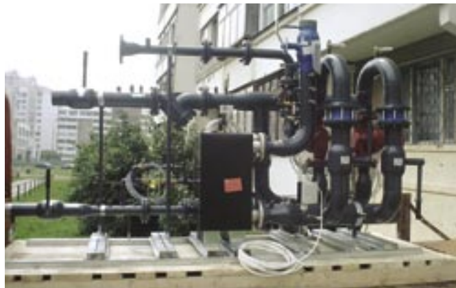
Использование БТП при реконструкции системы теплоснабжения 7-этажного 5-подъездного жилого дома
