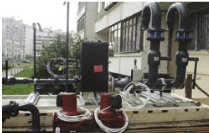
Монтажный проем для проноса оборудования имел очень малые габариты. Разборка БТП на отдельные модули для переноса в подвал жилого дома.
