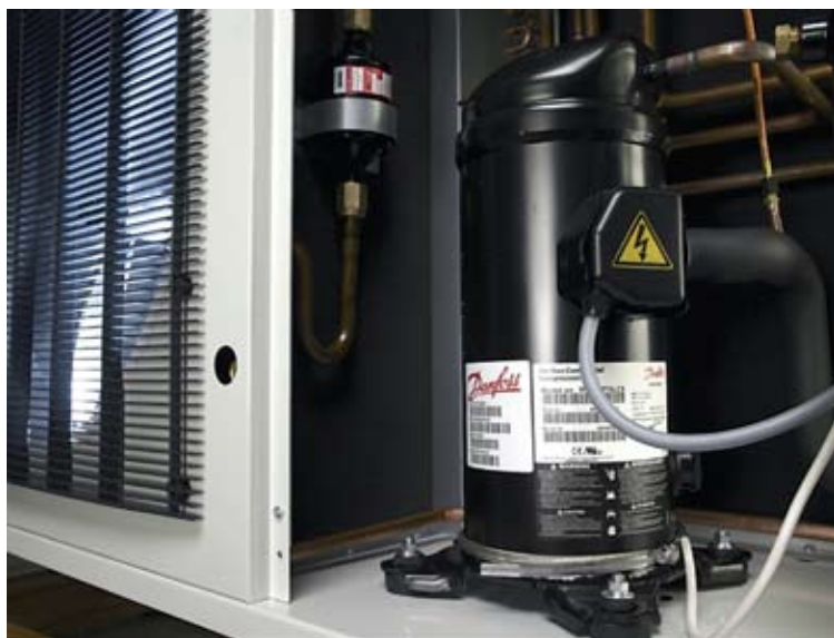
Спіральний компресор у компресорно-конденсаторному агрегаті «Optima Plus»
