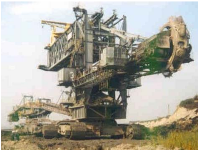
Rys. 3 – widok ogólny koparki SRs 1200
