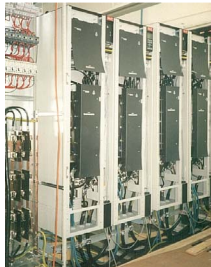
Rys. 4. Zespół szaf sterowniczych z przetwornicami częstotliwości VLT5125 w trakcie montażu
