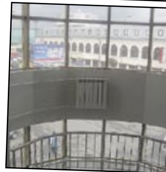
Высокий уровень отопления
